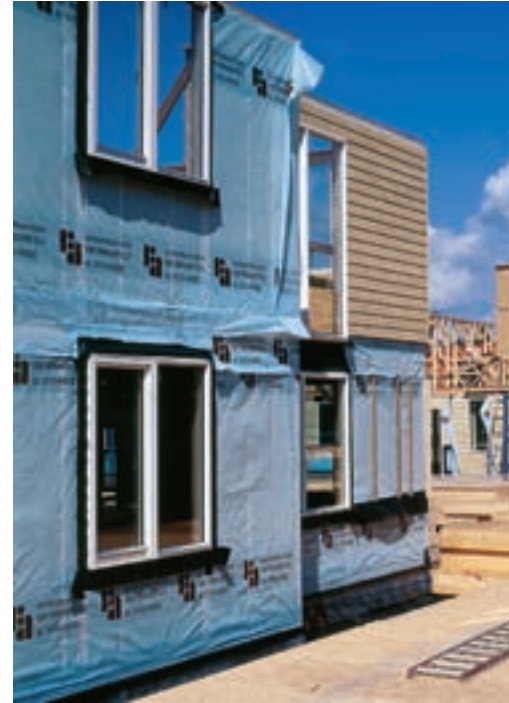
Montage hsb-wandelement in meerlaags project te Aalsmeer; ontwerp: Van den Berg van der Breggen Alphen a/d Rijn.
