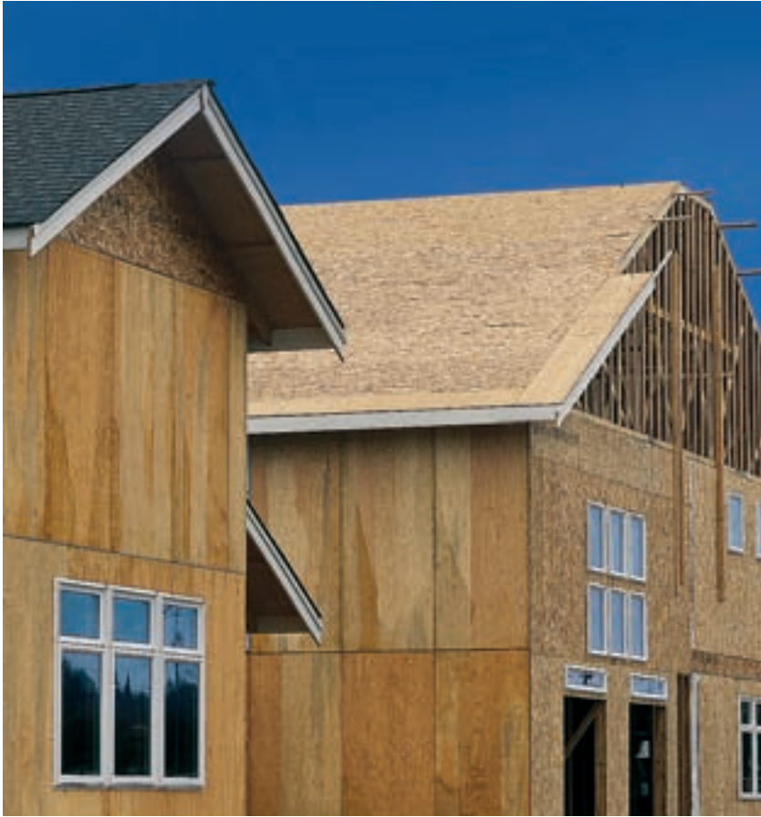
Houtbouw op z'n Noord-Amerikaans. Daar noemt men OSB tegenwoordig 'structural wood panel'.
