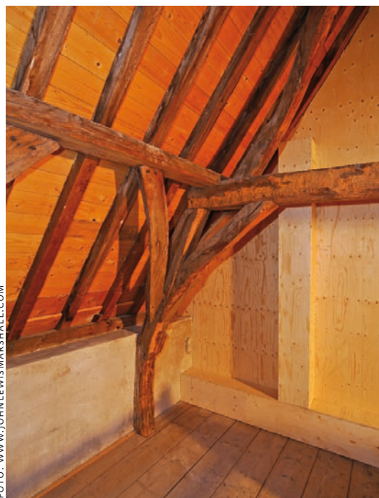
Kantongerecht Harderwijk; renovatiearchitect: Van Hoogevest Architecten Amersfoort. Ventryplex in wanden en (niet zichtbaar) drie- of vierlaags in de vloeren.
