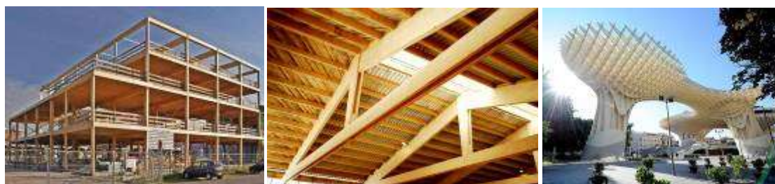
Figuur 9. Constructies in lvl: OPDC Saemstroom te Zaanstad (links) en hallenbouw (midden), Parasol te Sevilla (Spanje) rechts.
